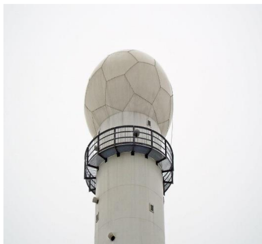
8 pav. Meteorologinis radaras.
